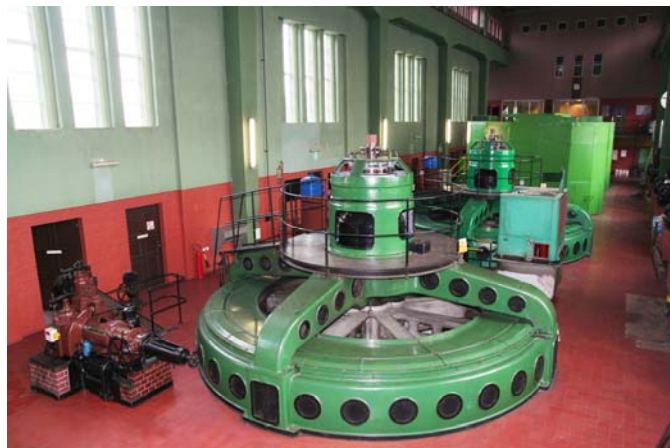
Pohled do strojovny VE Wroclaw I.
