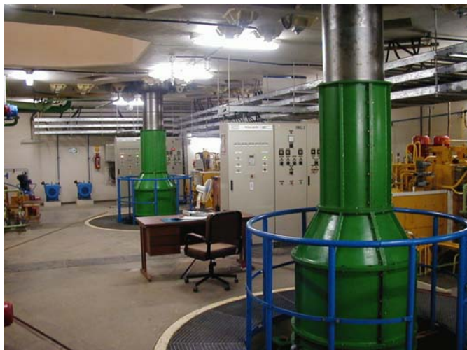
Strojovna VE Curumuy
